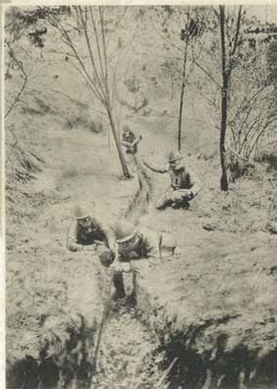
窪地に滞留するガスを防ぐ爲防毒 面を装着して通信用電線を檢する 佛國通信兵（A. G.）
