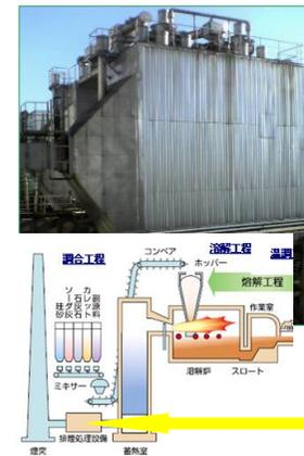
50KVの直流電圧を放電棒と集塵板に流すことによりコロナ放電を発生させ、ほこりを集塵する装置
