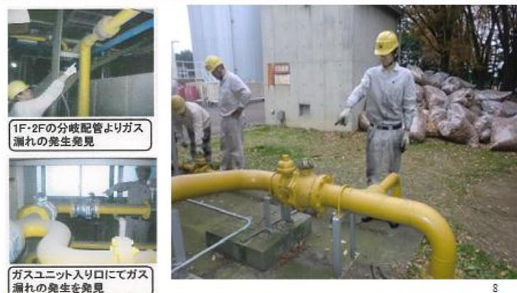
1F・2Fの分岐配管よりガス漏れの発生発見
