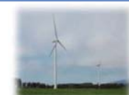
風力発電 (環境省HPより)
