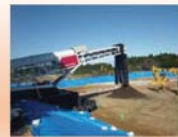
中間貯蔵施設 土壌貯蔵施設
