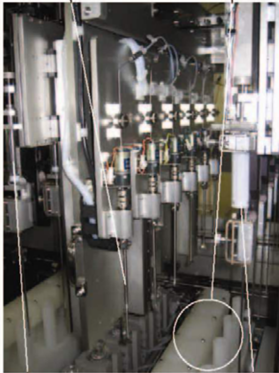
写真1 硫酸処理装置内部
