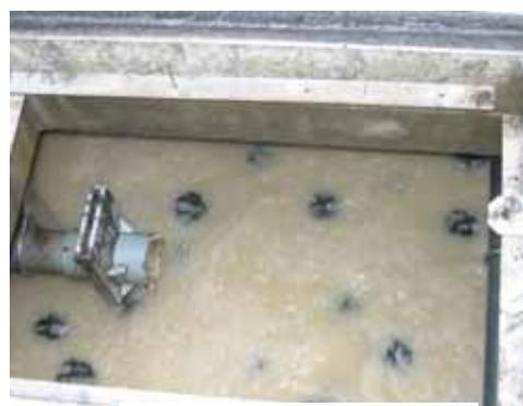
流動床接触ばっ気槽
