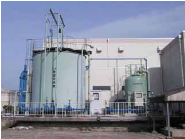
Máy lọc sợi cao tốc IFW (3 m 2 ) ở bên phải có cùng năng lực xử lý với thiết bị lọc cát (20 m 2 ) ở bên trái.
