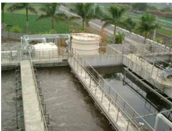
写真：異性化糖製造工程活性汚泥処理装置
