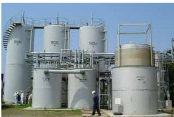
写真 食品工場醤油製造工程 UASB 嫌気性処理装置
