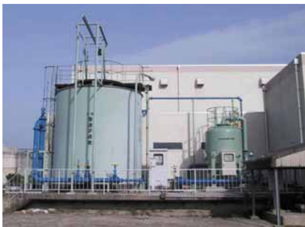
右：高速繊維ろ過機 IFW (3 m 2 ) 左：砂ろ過装置 (20 m 2 ) とともに同処理量 (2,500 m 3 / 日)
