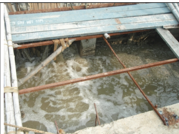
フィルターの状況（２） （竹製スクリーンが取り付けられていたのみである）
