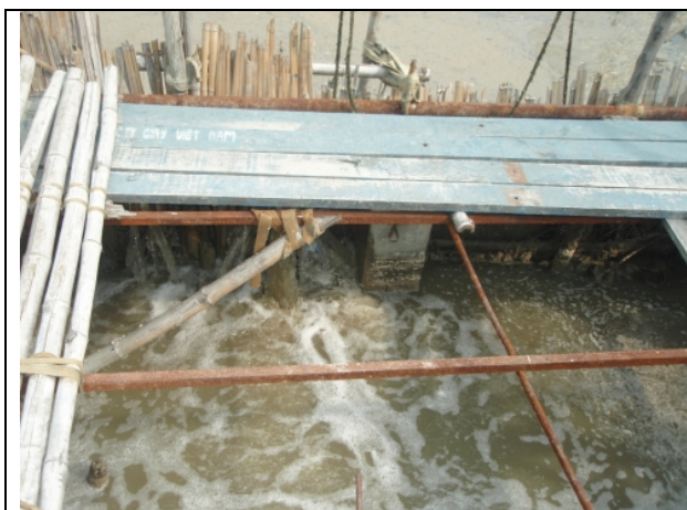
フィルターの状況（２） （竹製スクリーンが取り付けられていたのみである）
