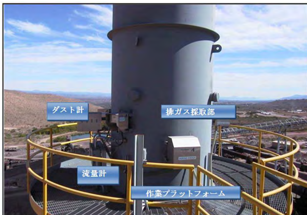
図 2-14 煙突中段へのセンサー部及び採取部設置例
