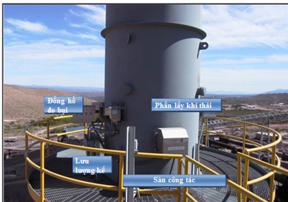
Hình 4-8: Ví dụ về việc lắp bộ phận lấy mẫu và bộ phận cảm biến vào tầng giữa ống khói
