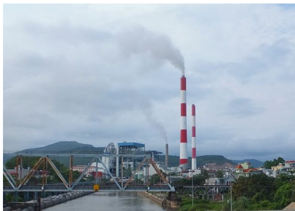
Hình 2-6: Tổ máy số 1 và số 2 Nhiệt điện Phả Lại
