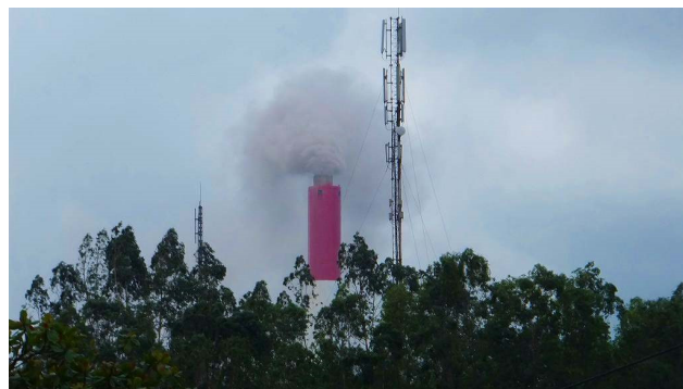
Hình 2-7: Tổ máy số 1 Nhiệt điện Uông Bí
