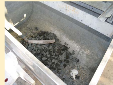
汚泥処理は濃縮した後にベルトプレス脱水
