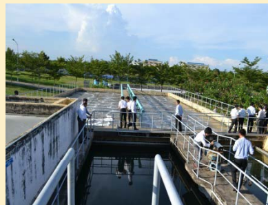
活性汚泥反応槽は全面曝気方式
