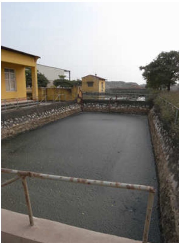
乳製品工場の排水処理
