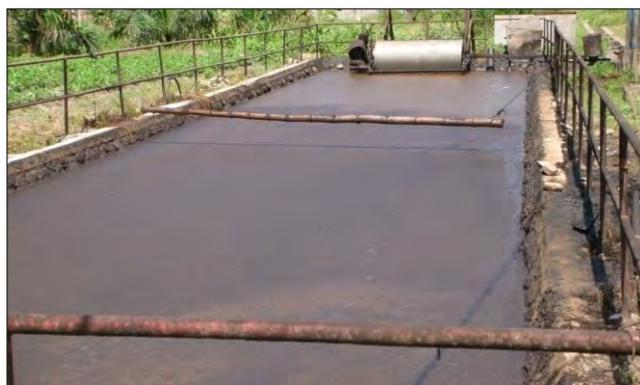
図 3-1-2 実際の油水分離装置の例
