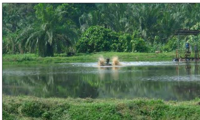
図 3-1-4 好気性生物処理池と曝気装置の例
