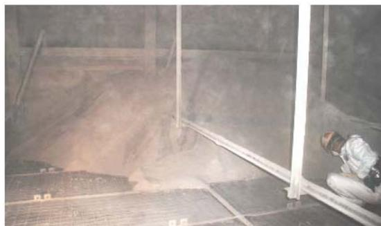
図4 脱硝装置入口部の灰堆積状態
