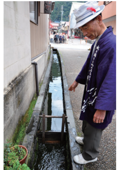
用水路の水を堰き止める「堰板」
