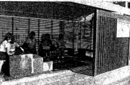
熊谷市役所のバス停前に設置された 休憩施設（23日、埼玉県熊谷市で）
