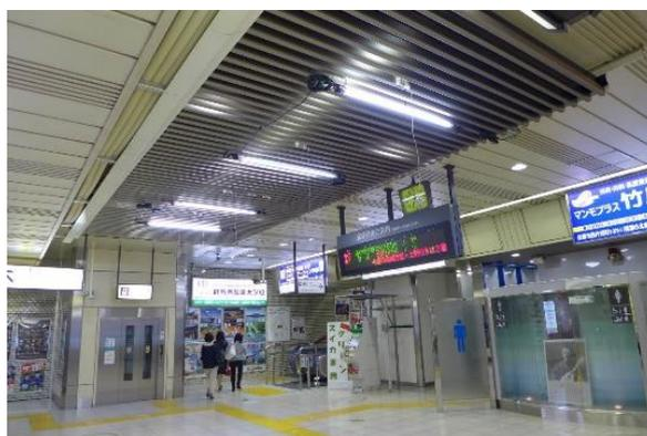
図 9.22 JR 前橋駅での天井冷房システム設置状況
