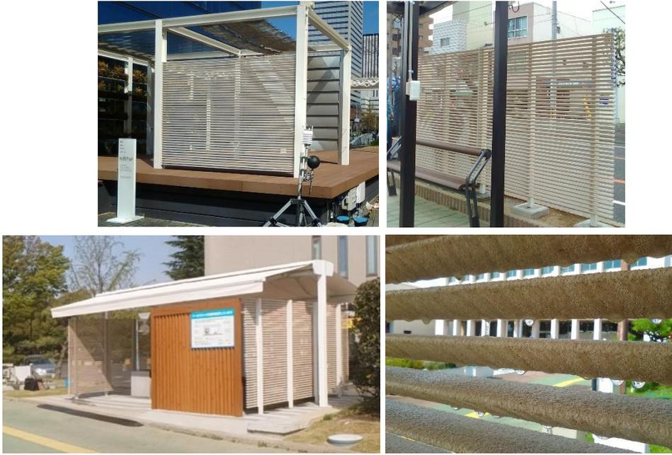
図 9.11 検証事業で設置した冷却ルーバー（上左：大阪市大阪ビジネスパーク、上右：堺市綾ノ町電停、下：熊谷市役所前バス停）
