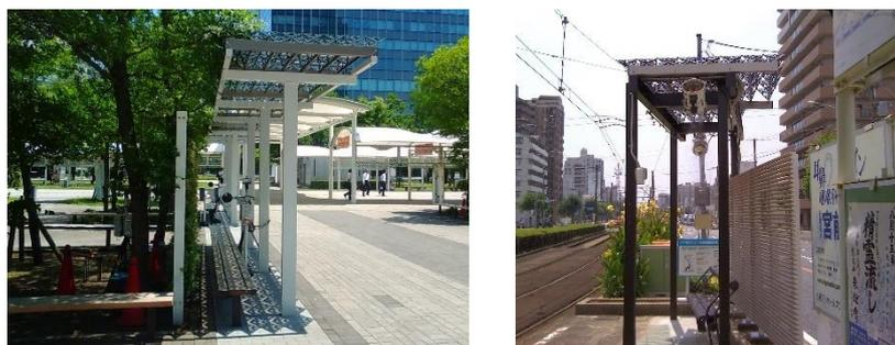
図 9.3 実証事業で設置したフラクタル形状日除け (左:東京ビッグサイト海上公園、右:堺市綾ノ町電停)
