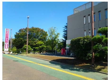
図 7.28 撤去工事完了状況写真
