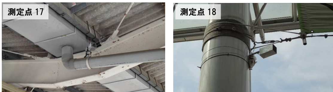
図 6.7 各測定点の機器設置状況③
