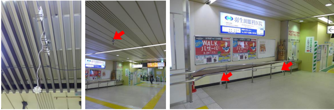
図 6.37 測定器の設置状況② (左：設備直下，中：スロープ天井，右：スロープ足元)
