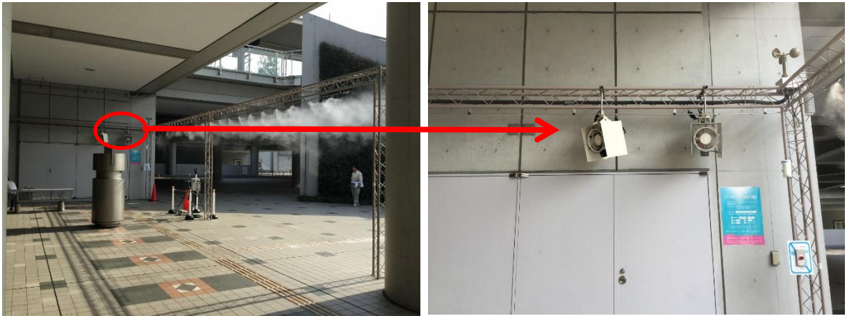
図 2.30 都営バス停留所「東京ビッグサイト」に設置されている Cool Jetter
