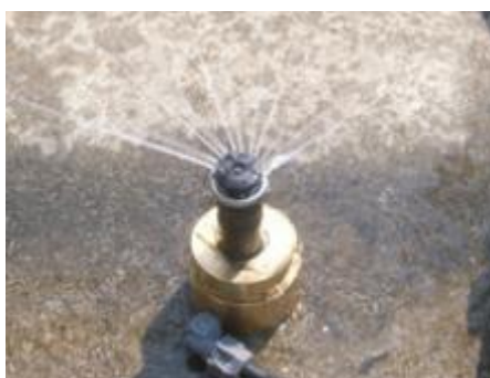
図 2.7 スプリンクラーによる給水例 10
