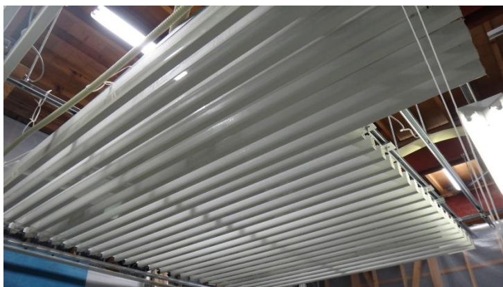
図 2.1 天井冷房システム
