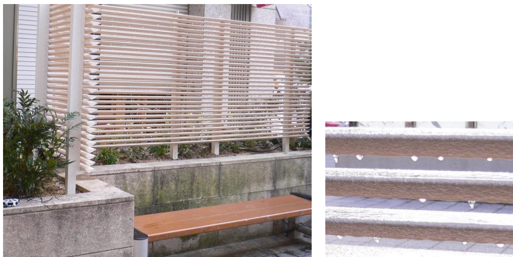
図 2.8 アルミ親水加工冷却ルーバーの設置事例（左 11) とルーバー表面の様子（右）
