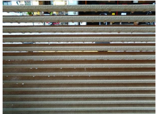
図 2.30 冷却ルーバーの給水の様子
