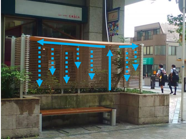
図 2.29 冷却ルーバー全景と給水経路イメージ
