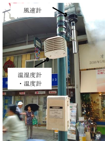
図 2.32 街灯への測器設置状況
