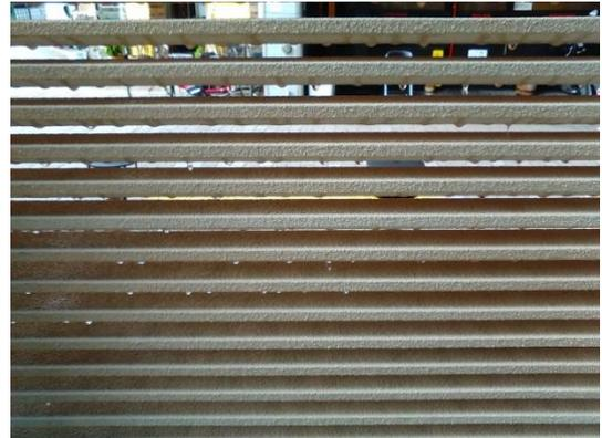
図 2.30 冷却ルーバーの給水の様子
