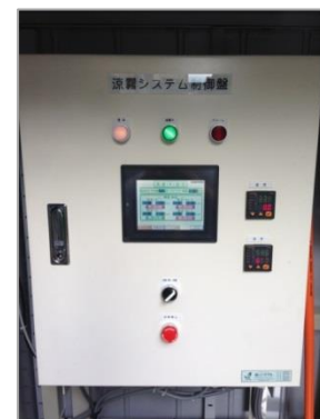
図 5.41 ドライ型ミストの制御盤
