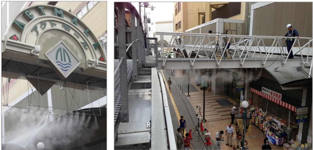
図 5.38 西側入り口のドライ型ミスト（左）、ドライ型ミストの本設置前の試行実験（右）
