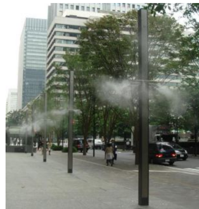
図 2-2 ミスト噴射装置
