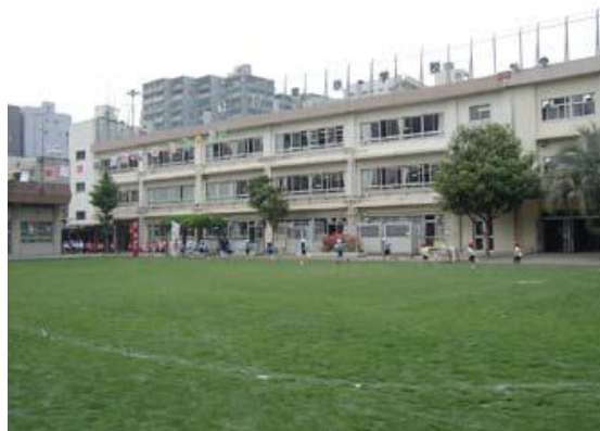
図 3-18 目黒区立下目黒小学校（東京都環境局HPより）
