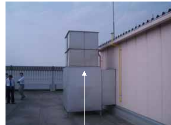
脱臭装置からの排気
