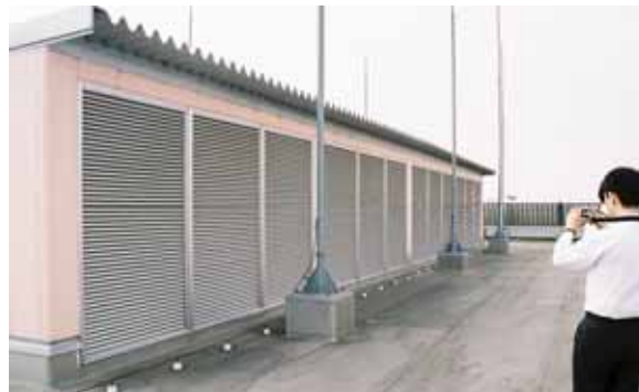
空調排気(局所排気含む)
