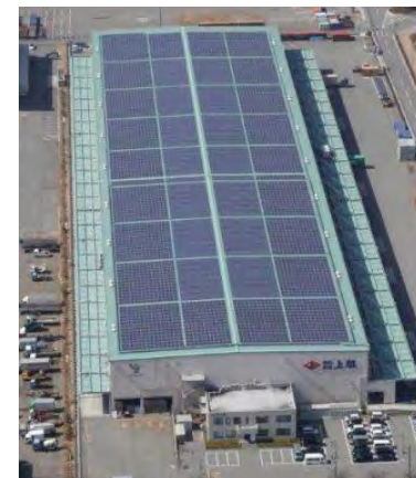
ポートアイランド （建物屋根、1.6MW）
