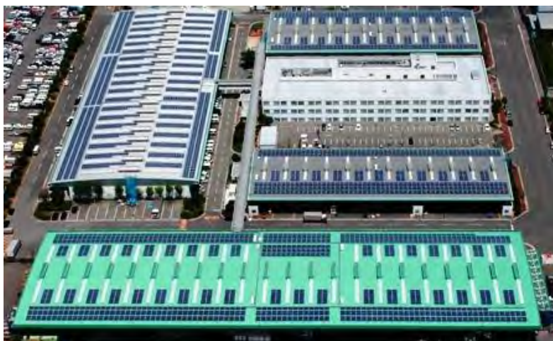
六甲アイランド（建物屋根、1.2MW）
