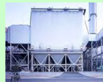
電気式集じん装置
