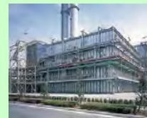
排煙脱硫装置
