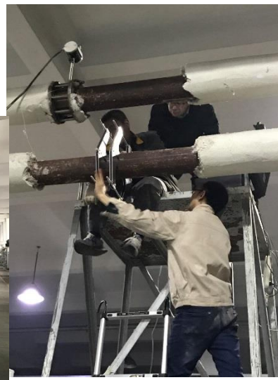
(エネルギー消費量測定の準備作業)
