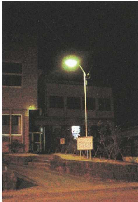
改修前（水銀ランプ）
