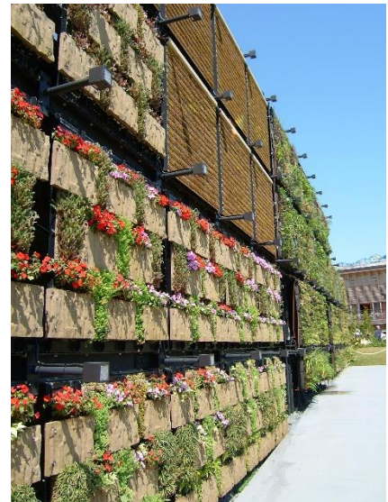
大規模壁面緑化「バイオラング」
