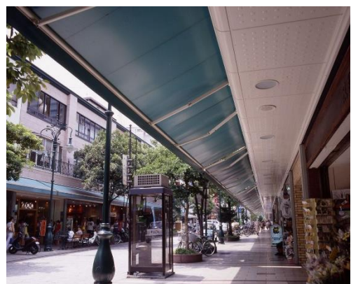
↑連続した日除け設置の例
