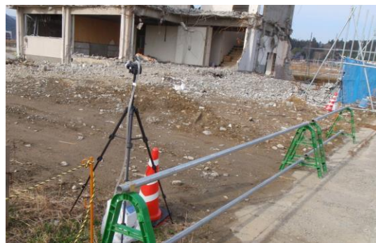
損壊建築物近傍での測定例
