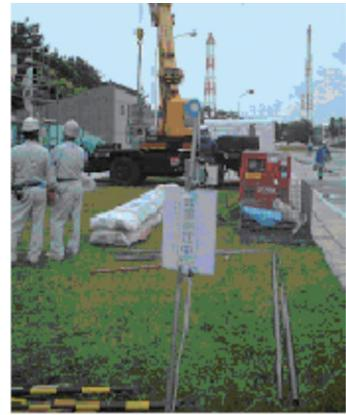
図3.102 折板をプラスチックシートで梱包後, クレーンで吊りおろしたところ
