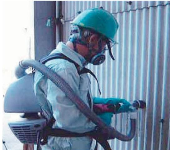
図3.111 機械工具による切断例
