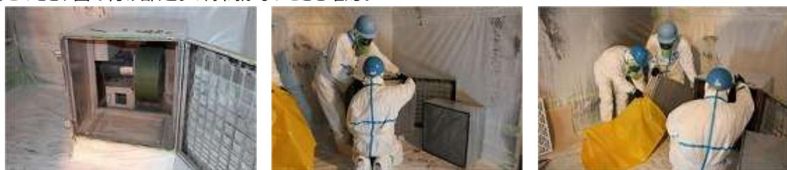
図 3.40 HEPA フィルタの交換
