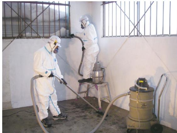
図 3. 73 高性能真空掃除機を用いた作業場内の仕上げ
