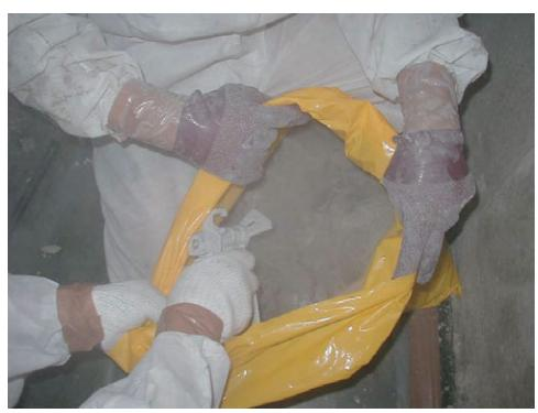
図3.67 袋詰めした石綿廃棄物への紛じん飛散防止処理剤を散布
