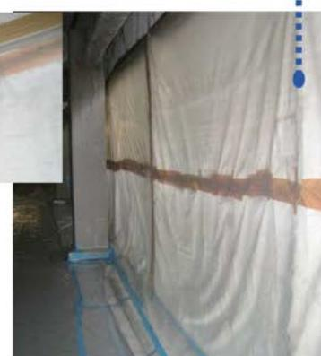
図 3.35 開口部の隔離養生（防炎シートの内側をプラスチックシートで隔離）
