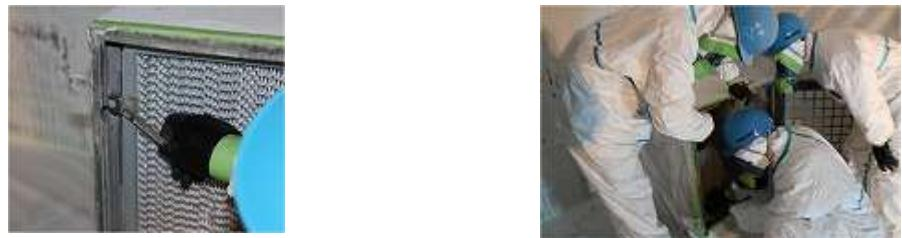
図 3.39 HEPA フィルタの留め付けの緩み点検
