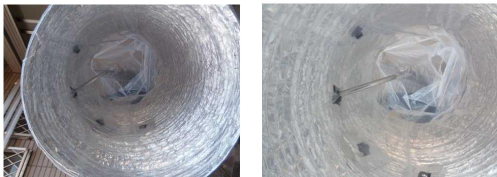
図 3. 125 等速吸引ノズルを使用した場合の排気ダクト内の測定例
