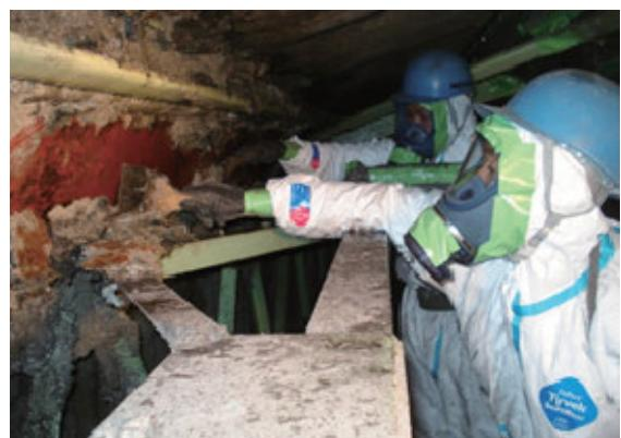
図 3. 64 手工具（ハラ）を使用した石綿含有吹付け材の除去作業
