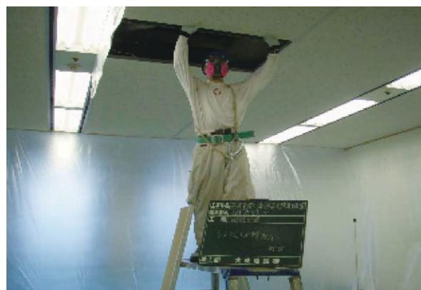
図 3. 110 天井石綿含有成形板の除去例
