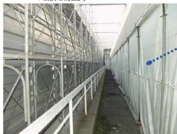
図 3.30 外壁開口部の飛散防止措置（開口部全面に防炎シートを張った。詳細は図 3.32）
