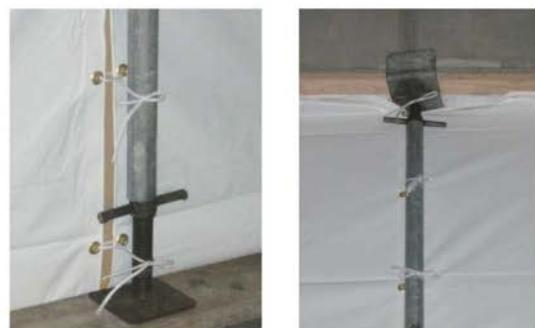
図 3.31 防炎シートの固定詳細（左：足元。単管にペースジャッキを挿入。右：頭部。単管に根太受け金物を挿入）
