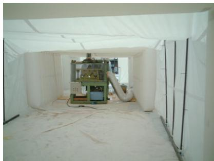
図3.103 吊りおろした折板を局所排気装置付切断機で切断するための切断ブース
