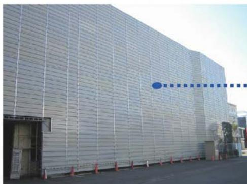
図 3.28 建屋周囲に設置した、通常の解体工事で使用する防音パネル（枠組足場に取付け、内部の石綿除去工事を視覚的にも遮断）
