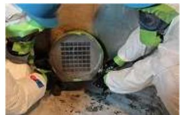
図 3.30 集じん・排気装置の排気口をプラスチックシート等で封鎖
