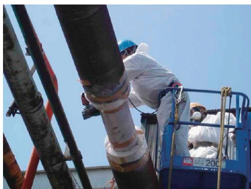
図 3.89 切断箇所の除去と養生
