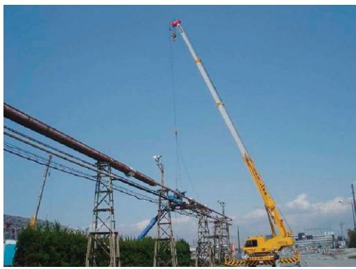
図 3.90 配管吊り降ろし
