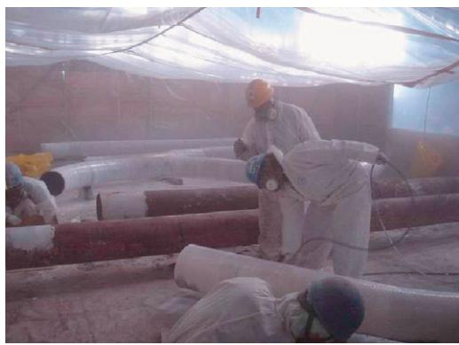
図 3.91 搭き落し作業
