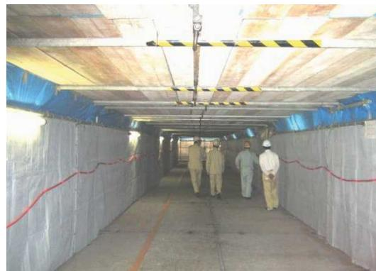
図3.14 駐車場ビルにおける施工区画(車路の両側及び上部吊足場が施工区画)
