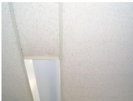
図 3. 106 石綿含有ロックウール吸音天井板
