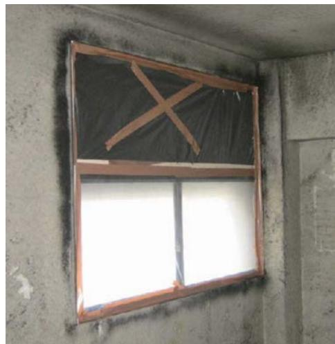
図 3. 27 窓、換気口の養生例
