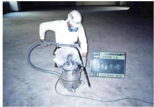
図 3. 115 清掃 高性能真空掃除機使用例
