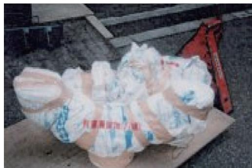
図 3.84 除去した保温材付配管を梱包、
