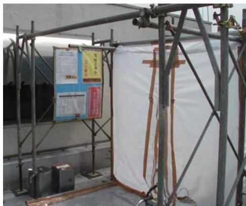
図 3.44 セキュリティゾーン前に設置した石綿障害予防規則に基づく表示及び掲示
