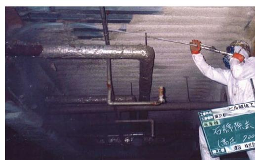
図3.56 ウォータージェット工法の例
