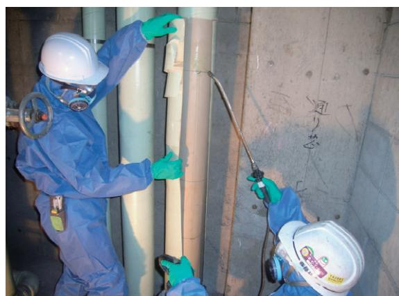
図 3.80 保温材の取外し
