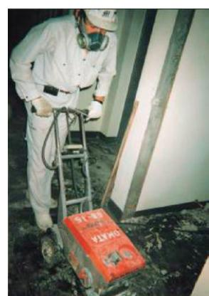
図 3. 114 石綿含有ビニルタイルの除去例
