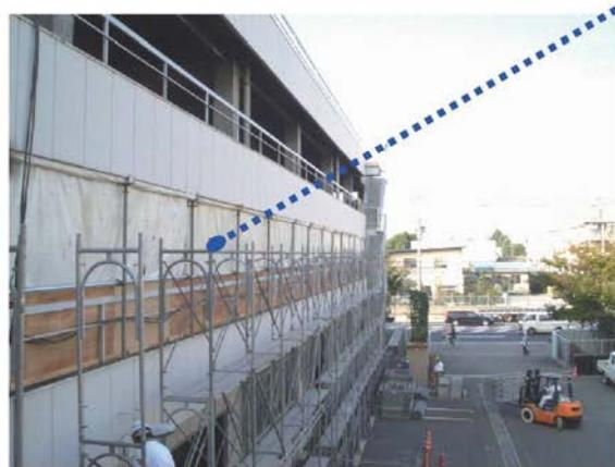
図 3.29 外壁開口部の飛散防止養生（既存手すりを活用し、防炎シートとベニヤ板を使用して隔離の破損を防止。）
