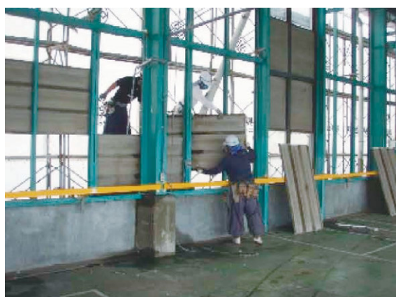
壁石棉含有成形板取外し
