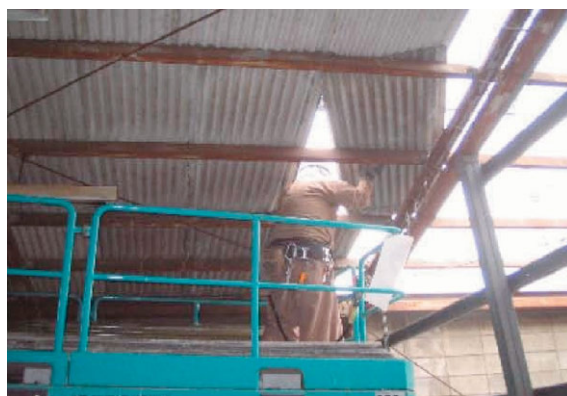
屋根スレート取外
