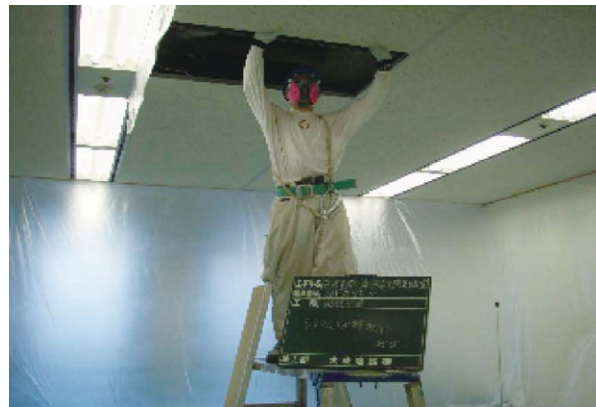
図 3.110 天井石綿含有成形板の除去例
