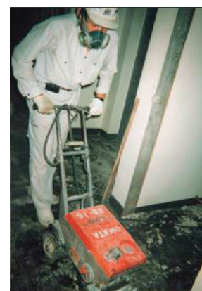
図 3. 114 石綿含有ビニルタイルの除去例
