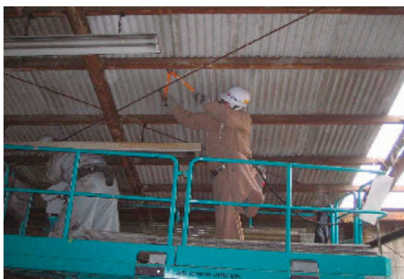
屋根スレート止め金物切断
