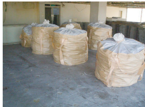
図 3. 116 石綿含有成形板廃棄物の保管例
