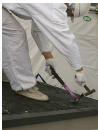
接合固定部分の取外し
