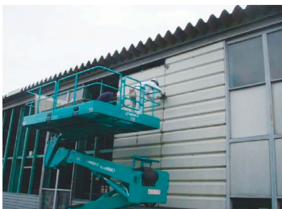
壁金物取外し
