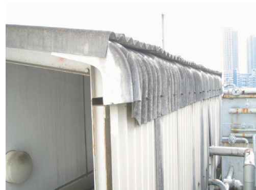
図 3. 105 石綿含有スレート波板
