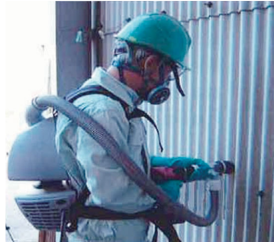
図 3. 111 機械工具による切断例
