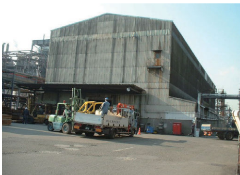
図 3. 105 石綿含有スレート波板
