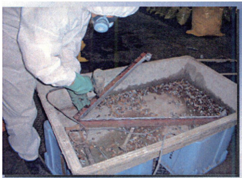
図 3. 118 掻き落とし除去作業の例
