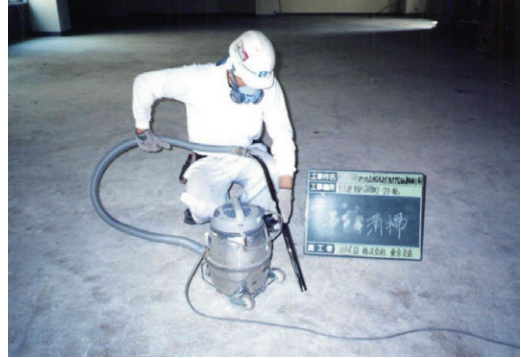
図 3. 115 清掃 高性能真空掃除機使用例
