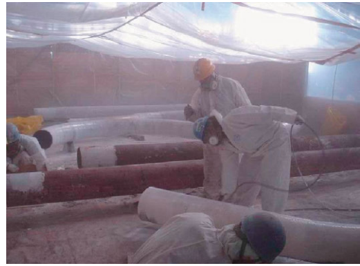
図 3.91 掻き落し作業
