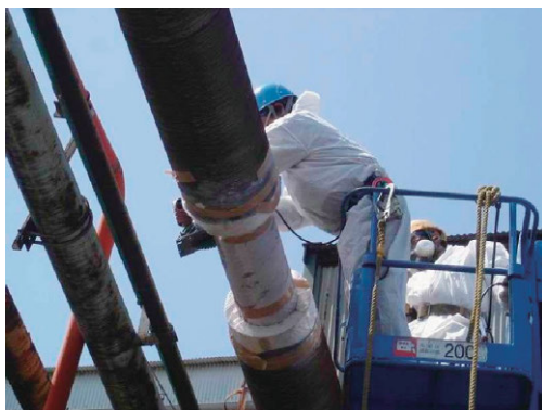
図 3.89 切断箇所の除去と養生
