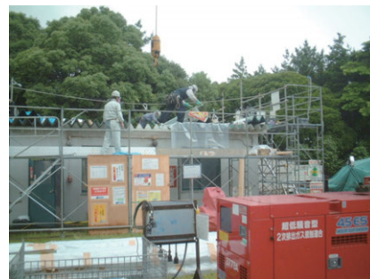
図3.104 折版をはがしているところ
