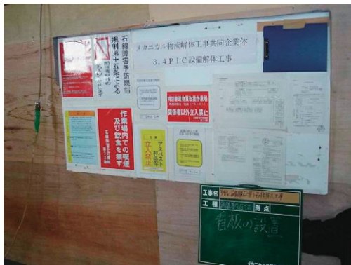
図 3.87 屋外蒸気配管用における掲示
