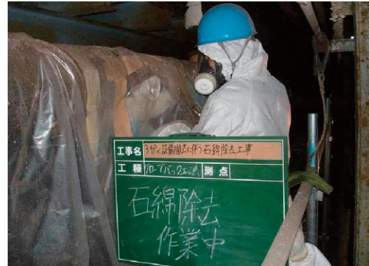
図 3.97 石綿除去作業中 1
