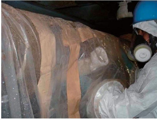
图 3.98 石棉除去作業中 2
