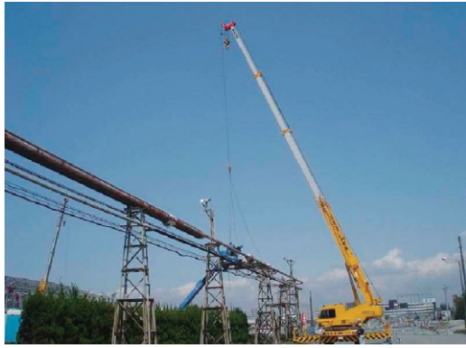
図 3.90 配管吊り降ろし
