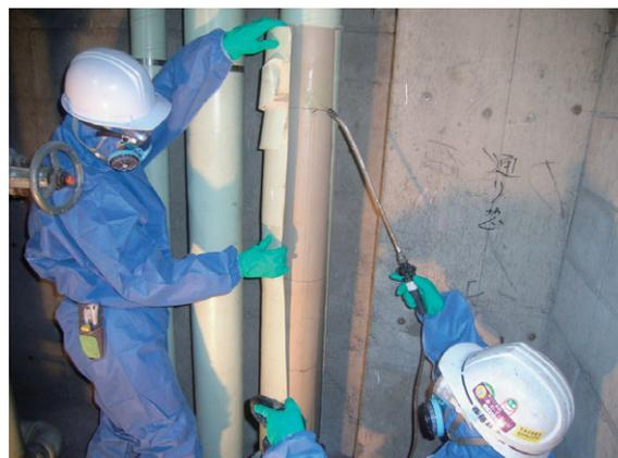
図 3.80 保温材の取外し
