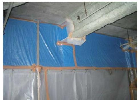
図 3.25 壁面の隔離養生例 (作業場内側)
