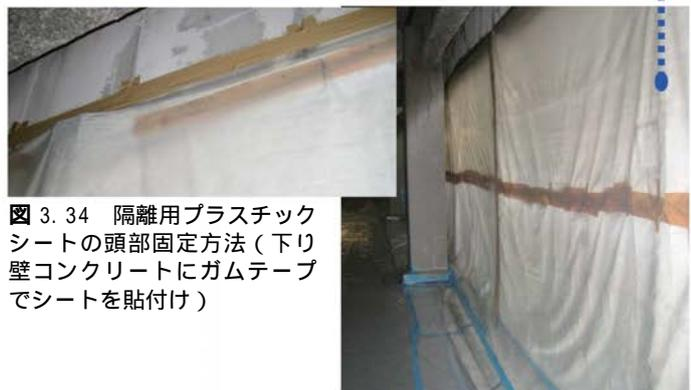
図 3.34 隔離用プラスチックシートの頭部固定方法（下り壁コンクリートにガムテープでシートを貼付け）
