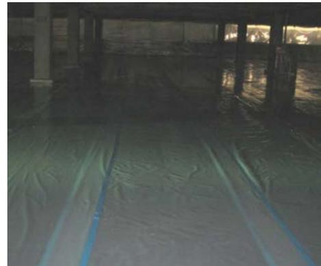
図 3.24 床面の隔離養生例 (2重張り)
