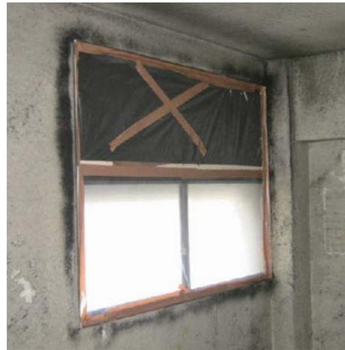
図 3. 27 窓、換気口の養生例
