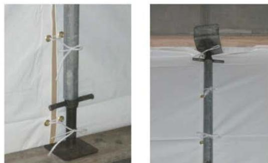
図 3.31 防災シートの固定詳細（左：足元。単管にベースジャッキを挿入。右：頭部。単管に根太受け金物を挿入）
