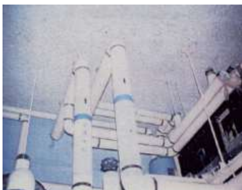
（吸音・断熱材：機械室の壁・天井）
