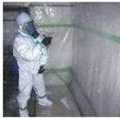
図 3.28 養生シートへの散布
