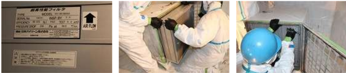
図 3.41 フィルタの取り付け
