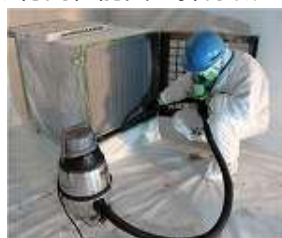
図 3.38 HEPAフィルタ等の清掃
