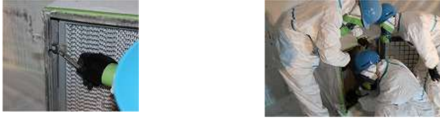
図 3.39 HEPAフィルタの留め付けの緩み点検
