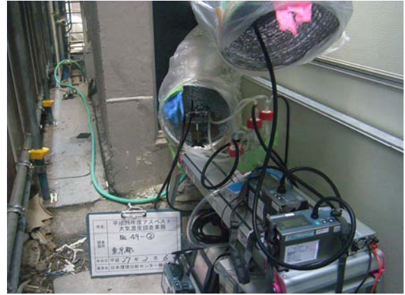
調査地点②(集じん機排気口)
