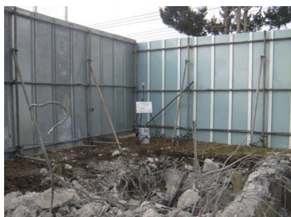
調査地点④(敷地境界)
