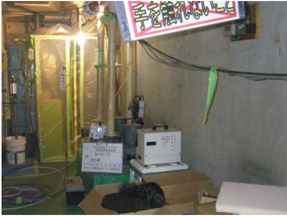
調査地点①(セキュリティ出入口外側)
