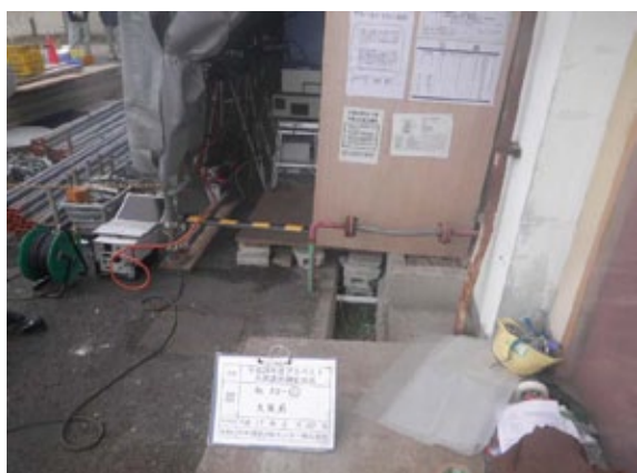
調査地点①(セキュリティ出入口内側)
