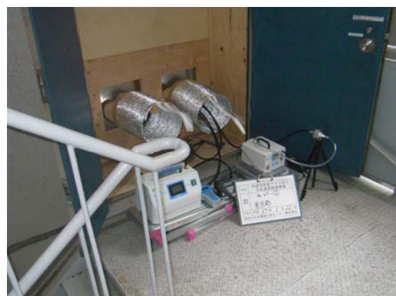
調査地点②(集じん機排気口)
