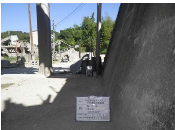
調査地点⑤(破碎機付近)
