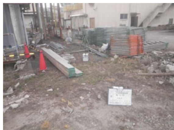
調査地点④(敷地境界)
