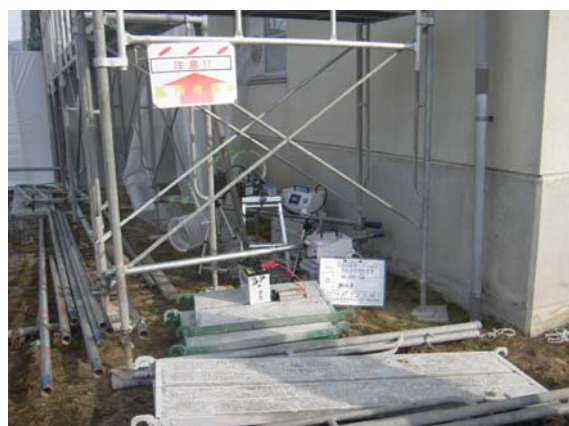
調査地点②(集じん機排気口)
