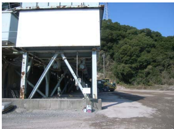
調査地点①(破碎機付近)
