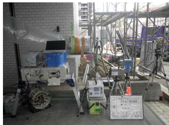
調査地点②(集じん機排気口)
