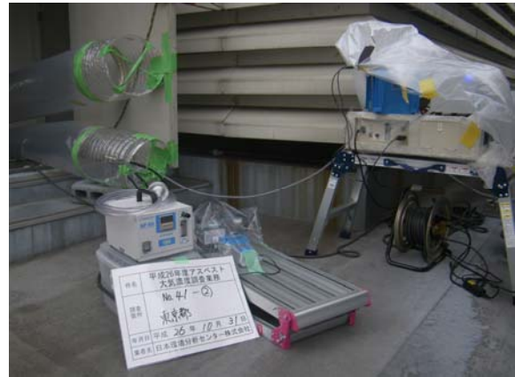
調査地点②(集じん機排気口)
