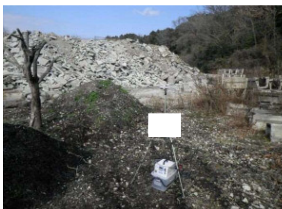
調査地点③(破碎施設敷地境界)
