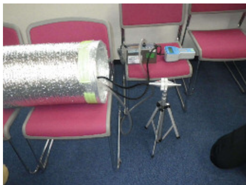
写真 I - 1 ダクト内設置状況
