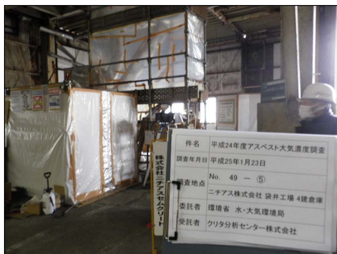
調査地点⑤(前室)
