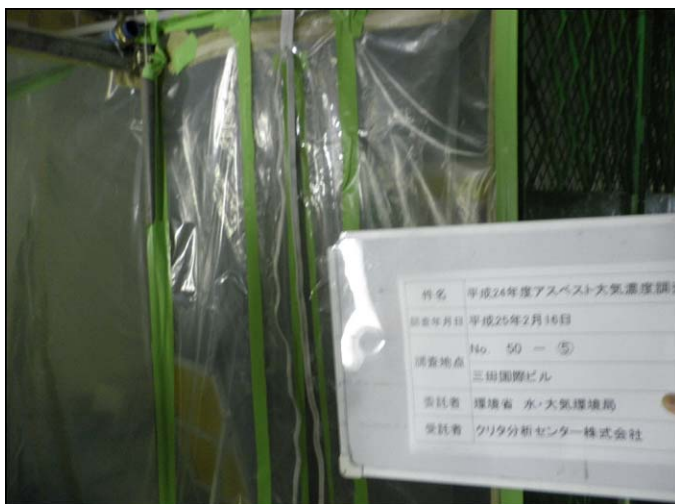
調査地点⑤(前室)
