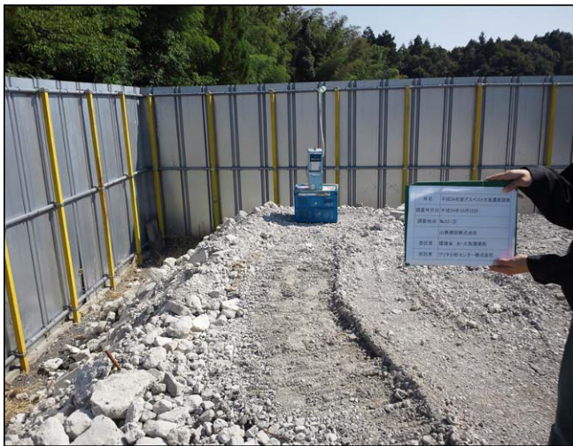
調査地点③(破砕施設敷地境界)
