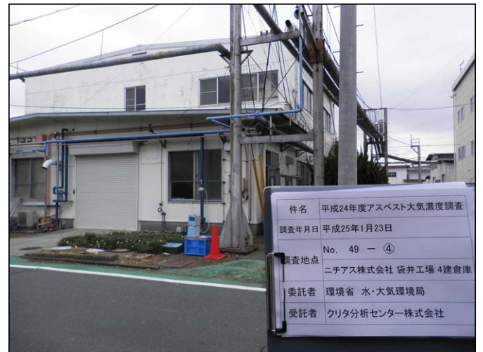
調査地点④(建物周辺)
