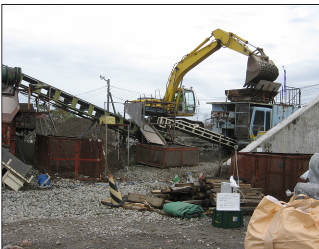
調査地点⑤(破碎機付近)
