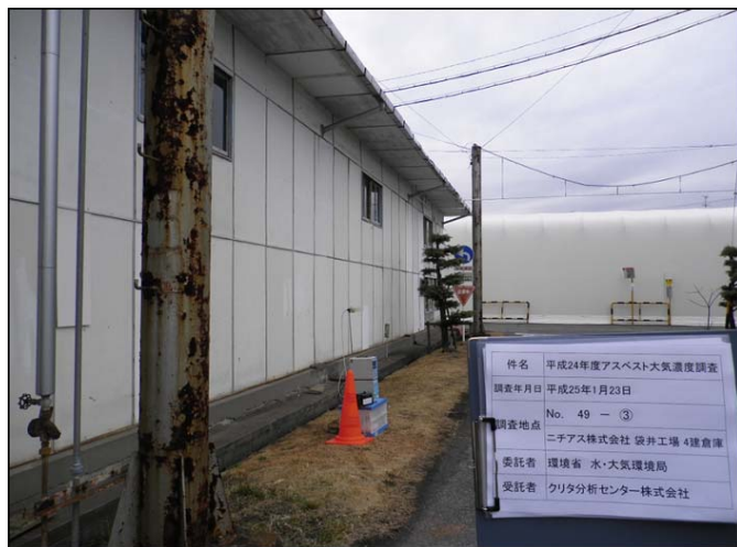
調査地点③(建物周辺)
