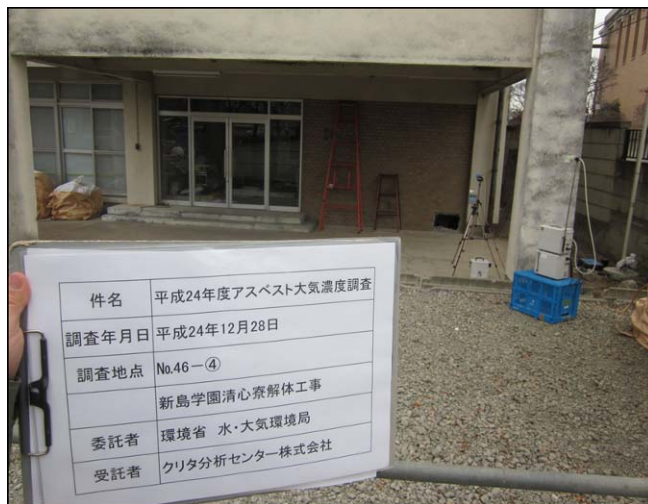
調査地点④(建物周辺)
