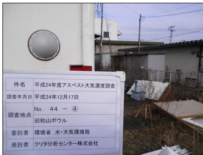
調査地点④(建物周辺)
