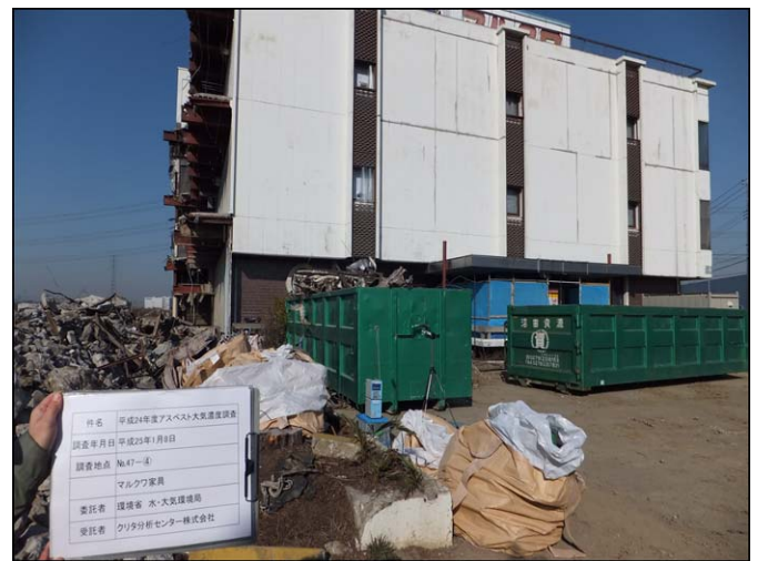
調査地点④(建物周辺)
