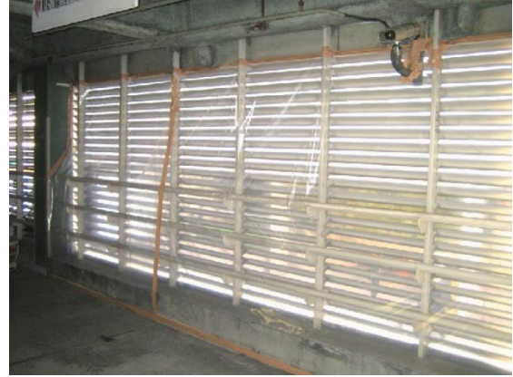
図 4.7.24 外壁の隔離例 (ガラスの手前をプラスチックシート等で隔離)
