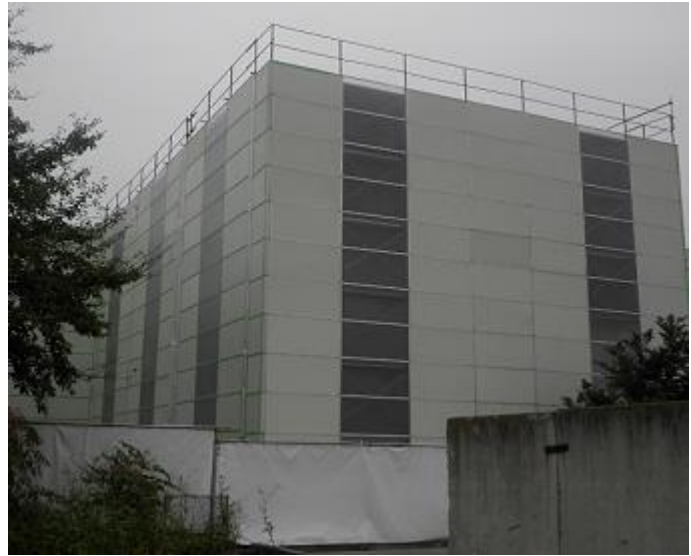
図 4.7.33 防音パネル／採光防音パネル施工例
