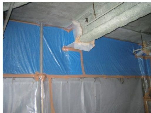
図 4.7.12 壁面の負圧隔離養生例 (作業場内側)
