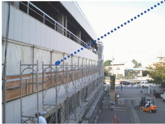
図 4.7.18 外壁開口部の飛散防止養生（既存手すりを活用し、防災シートとベニヤ板を使用して負圧隔離養生の破損を防止）
