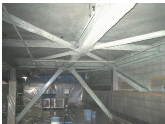
図 4.7.5 同上施工区画の内部側
