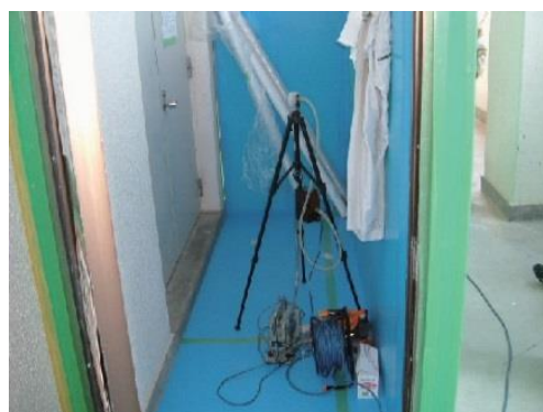
図 4.7.8 同左施工区画 (内部)
