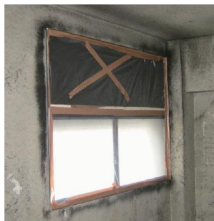
図 4.7.14 窓、換気口の負圧隔離養生例
