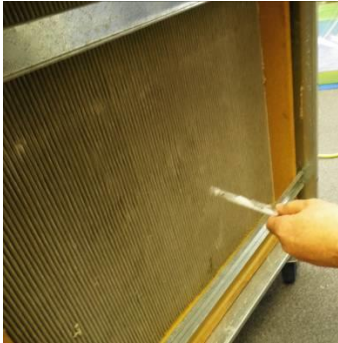
図 4.7.48 HEPA フィルタ面
