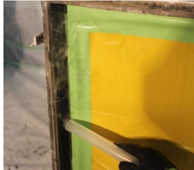
図 4.7.49 HEPA フィルタ周辺部分
