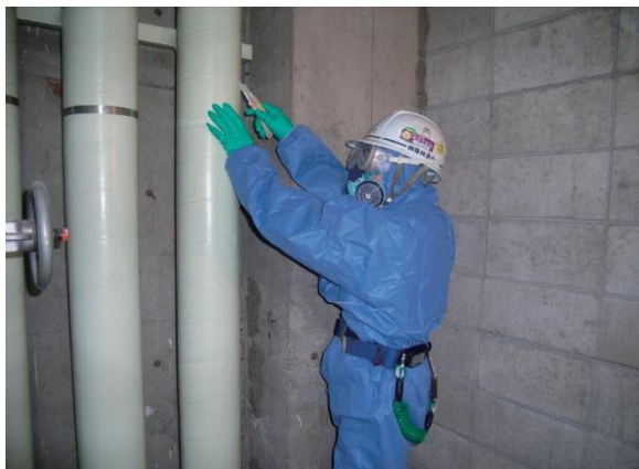
図 4.8.2 保温材被覆撤去
