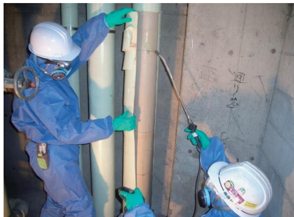
図 4.8.3 保温材の湿潤化→取り外し
