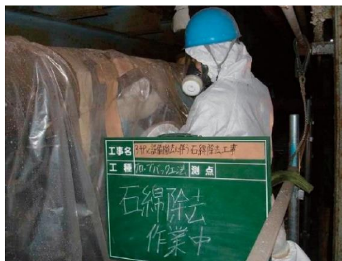
図 4.10.9 石綿除去作業中 1
