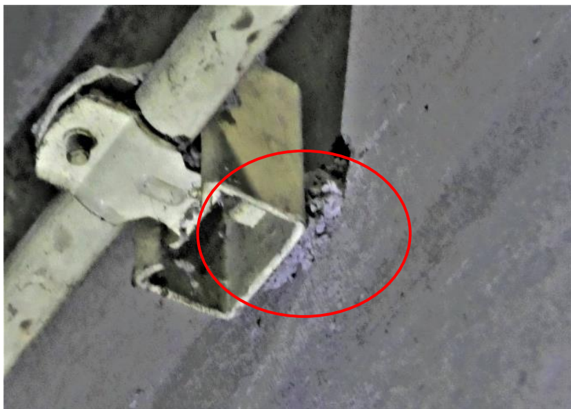
電線管ダクター部の清掃不良
