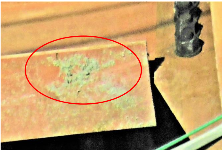
鉄骨梁下の取り残し
