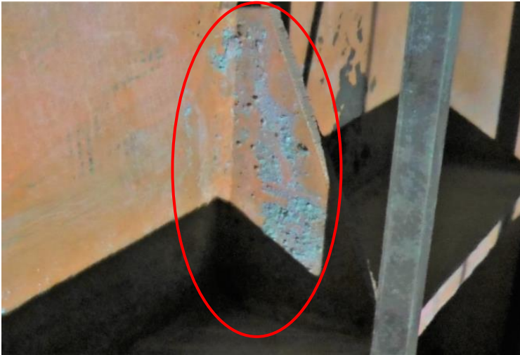
鉄骨梁側面の取り残し
