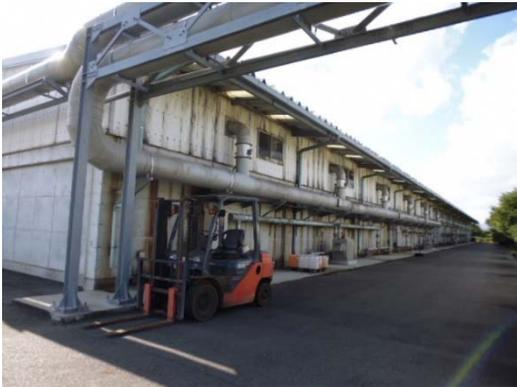
写真5 堆肥棟の発酵槽から吸引したガス
