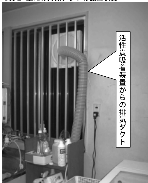
写真2 室内の排気ダクトの設置状態
